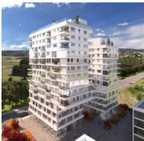
Luxembourg : Capelli Towers Tours de 13 et 15 étages 100 logements & 2123 m 2 de bureaux Chiffre d'affaires : 47 M€
